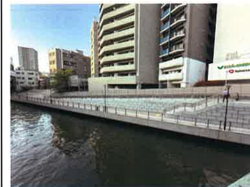
右岸整備済箇所
