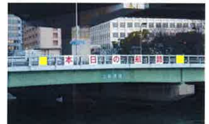
上船津橋設置状況
